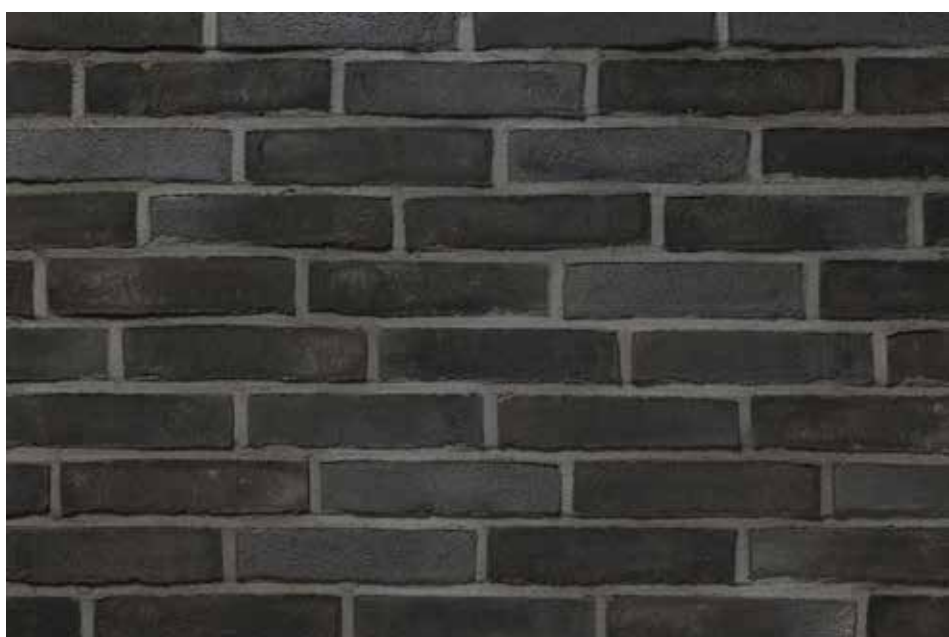
Verblendmauerwerk Klinker, wilder Verband
