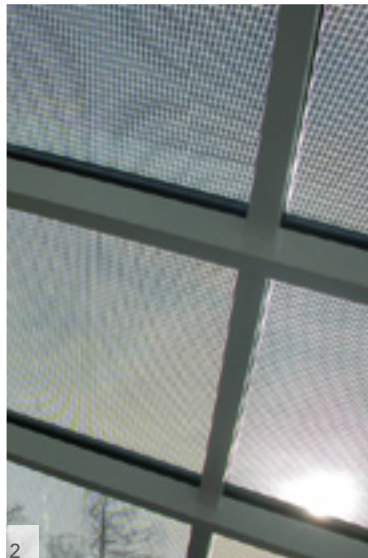
2-3 | Glasintegrierte, semitransparente Photovoltaik mit guter Durchsicht Glass-integrated, semitransparent photovoltaic with good view
